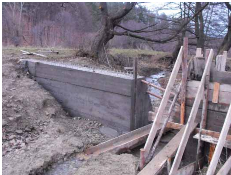
60. ábra: A kis gát építése a mellékpatakon
