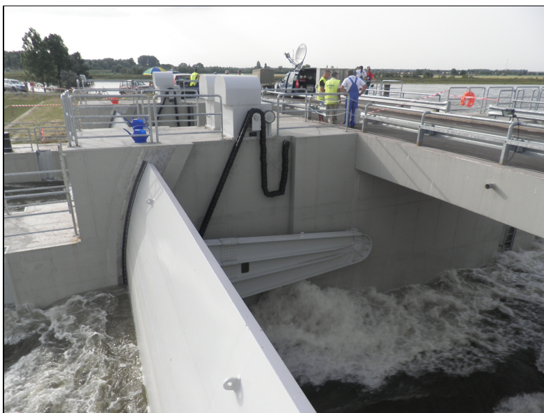
Otvorené stavidlo výpustného objektu Tiszaroff dňa 14. júna 2010
